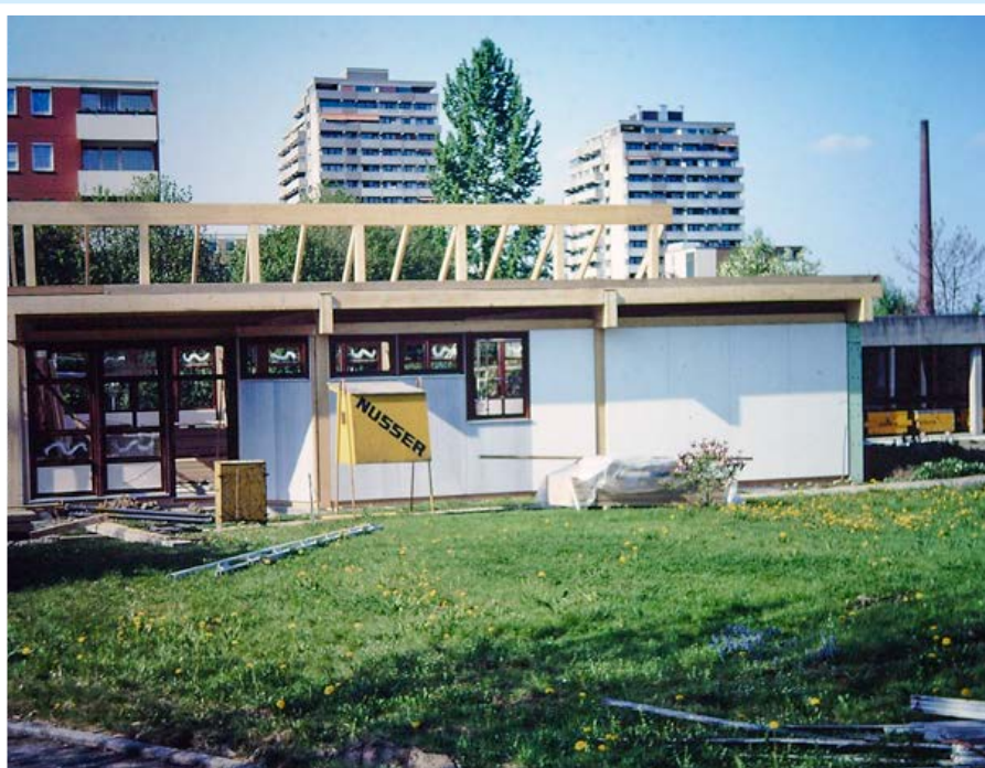
Bau des großen und des kleinen Saals
